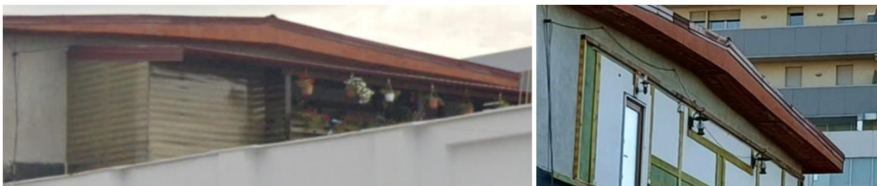
Foto înainte și după: Construcție neautorizată (extindere tip terasă) desființată pe cheltuiala debitorului în urma unui titlu executoriu
